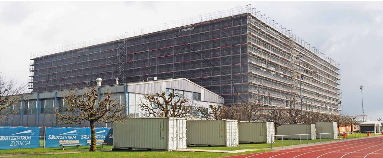
Im Vordergrund steht aktuell noch die bisherige Dreifach-Turnhalle, die nach der Fertigstellung des neuen Sportzentrums rückgebaut wird.
