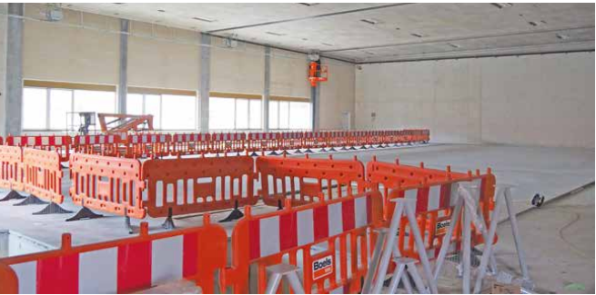
Die Kunstturnhalle der Frauen befindet sich im Erdgeschoss. Mitte Mai werden die Geräte von Alder + Eisenhut geliefert und montiert. Bis dahin erfolgen die letzten Feinarbeiten.
