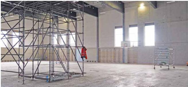
Auch in der Dreifachturnhalle auf Ebene 1 nimmt die Ausstattung konkrete Formen an: Die Schaukelringe sind bereits installiert, ebenso die Basketballkörbe und Sprossenwände. Insgesamt werden hier rund 90 Bodenverankerungen eingebaut.
